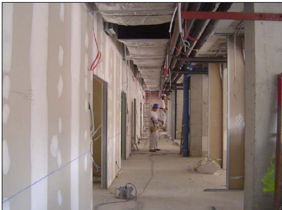
Obras del CIBA
