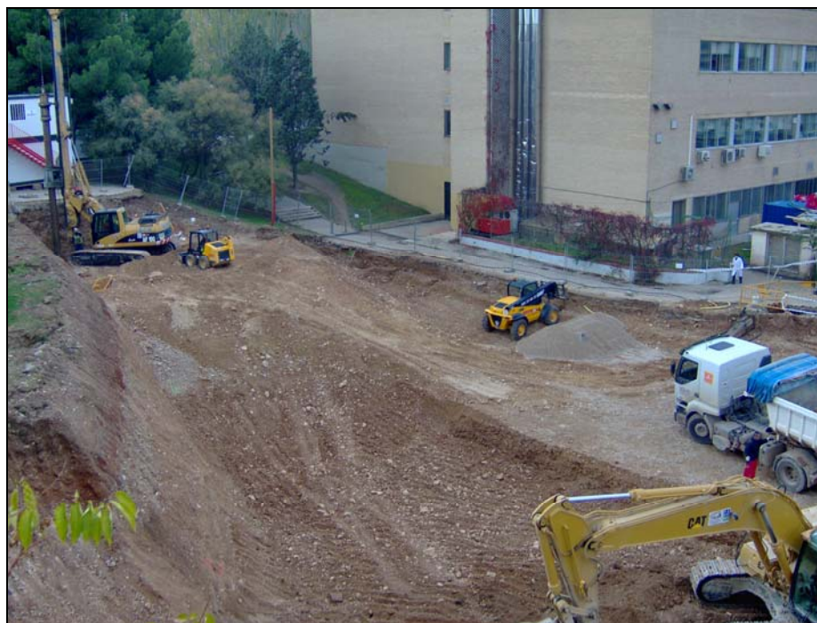
Obras del CIBA
