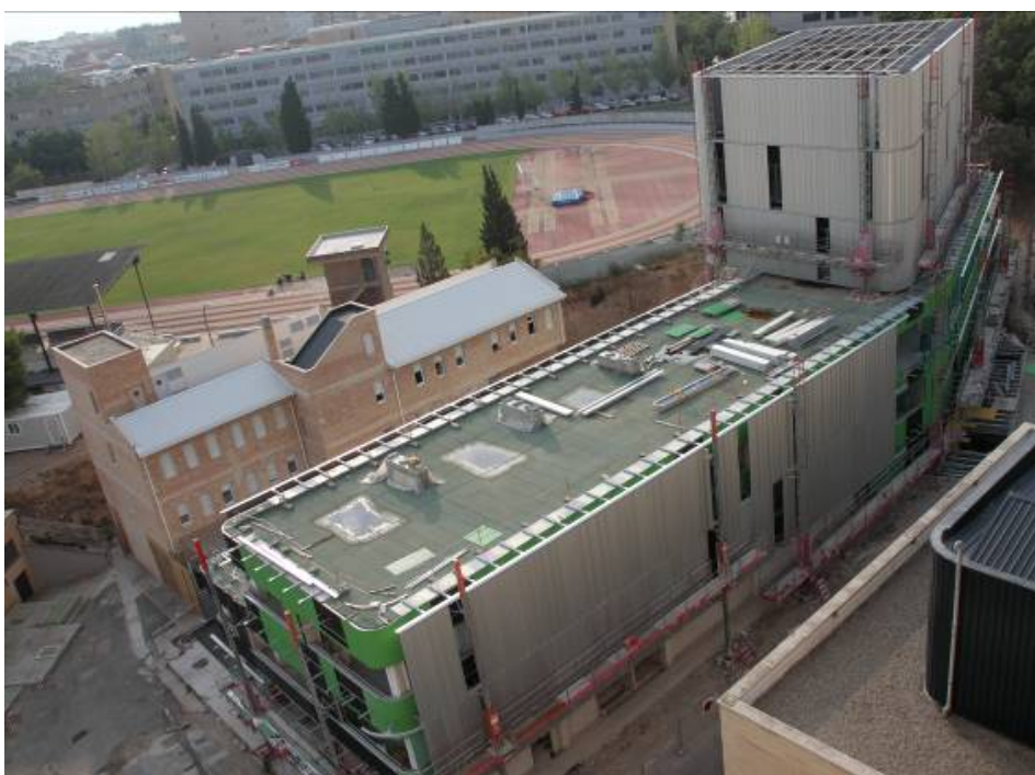
Obras del CIBA
