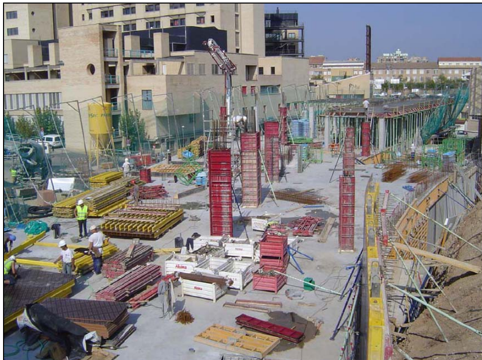
Obras del CIBA
